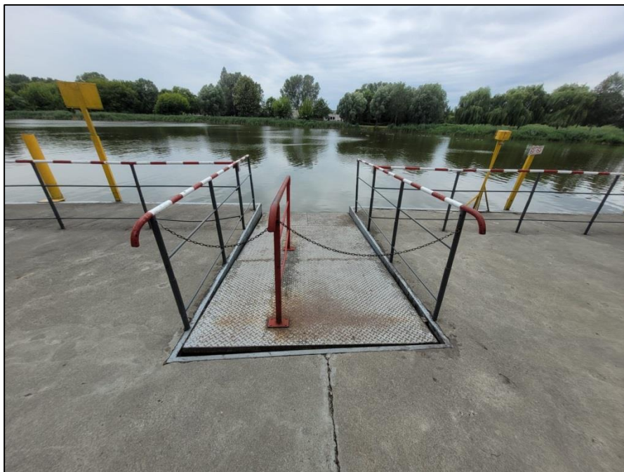
Foto. Miejsce cumowania statku pasażerskiego „Rusałka” - Wejście Źródło: Nadgoplańskie WOPR
