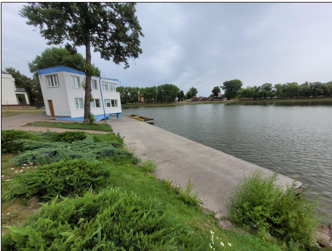
Foto. Budynek sędziowski toru regatowego na jeziorze Gopło na Półwyspie Rzepowskim w Kruszwicy
