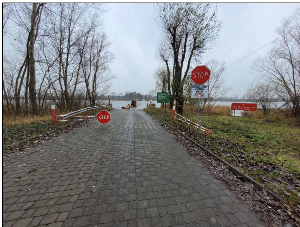
Foto. Slip przeprawy promowej prawy wschodni Złotowo Źródło: Nadgoplańskie WOPR
